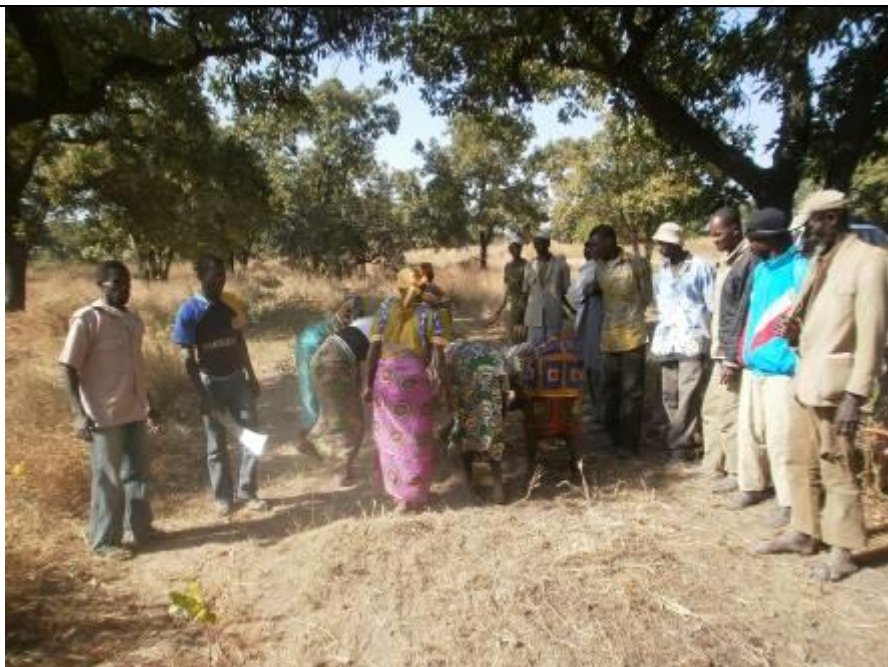
Photo 5 : Réalisation d'un pare-feu pour la protection des plantations
